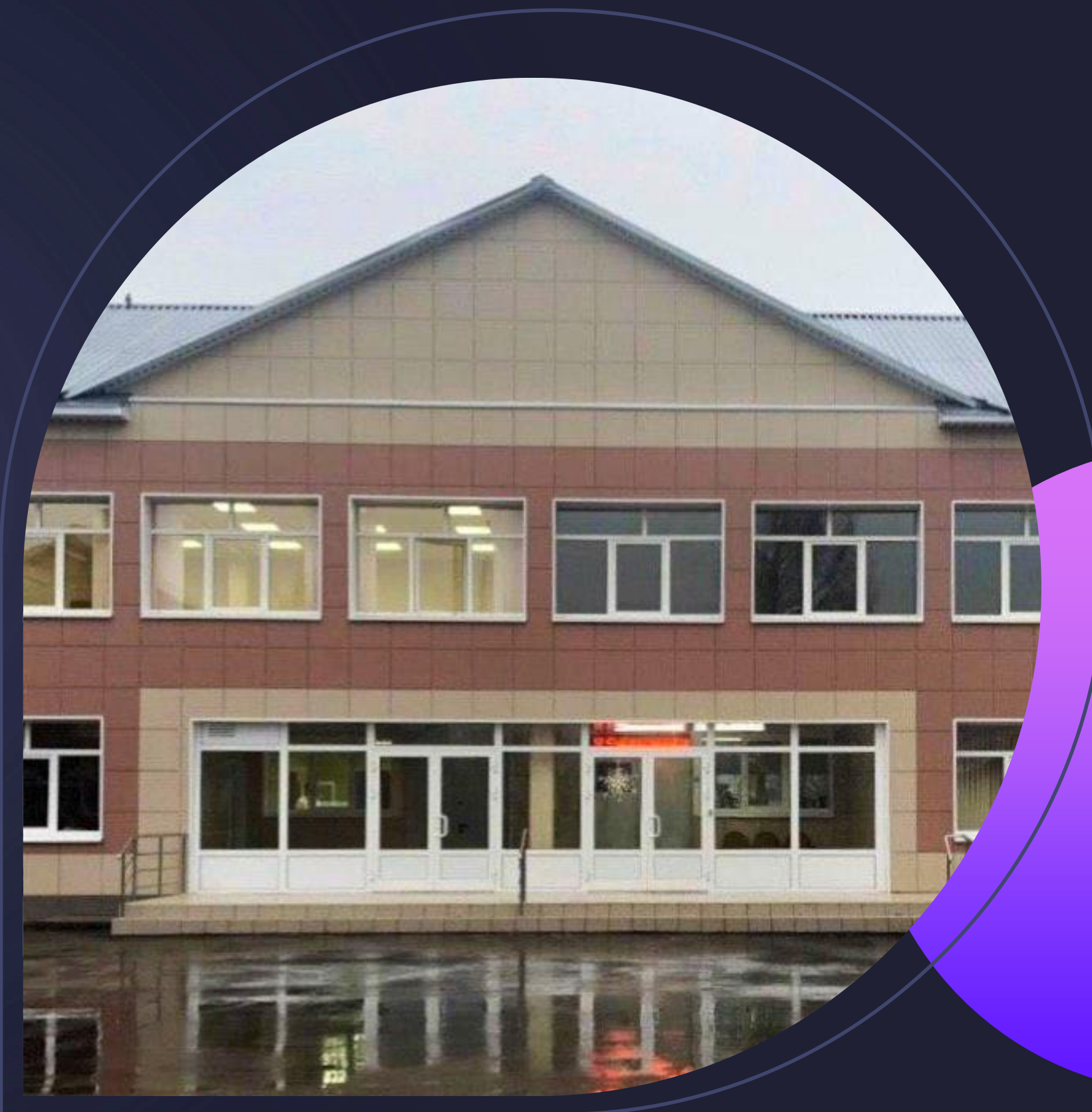
Спасская школа после капитального ремонта
